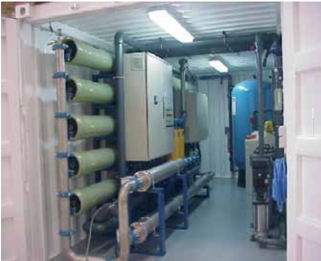
Рис. 2. Стационарная установка водоочистки
